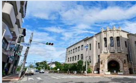
電柱抜柱後のイメージ
